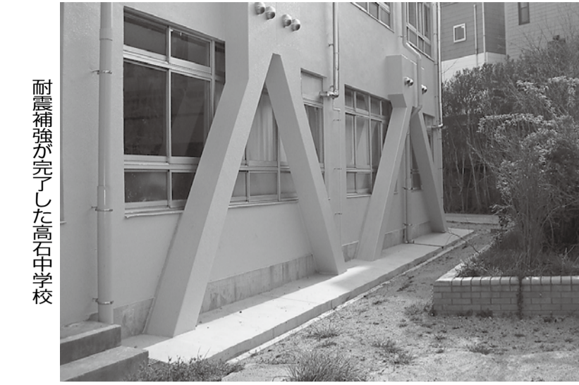
耐震補強が完了した高石中学校
